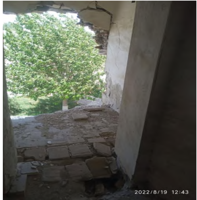
2-расм. Мадраса деворларидаги дарзларнинг очилиши ва емирилиши жараёнлари
