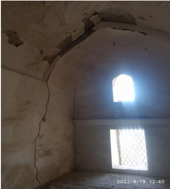
2-расм. Мадраса деворларидаги дарзларнинг очилиши ва емирилиши жараёнлари
