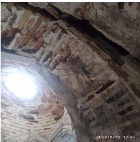
3-расм. Бинонинг таъмирланиши зарур бўлган қисмлари.
