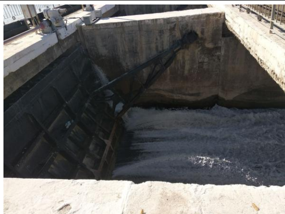
Рис. 10. Водораспределительное сооружение «Бош Шофиркон» (Шафирканский район)
