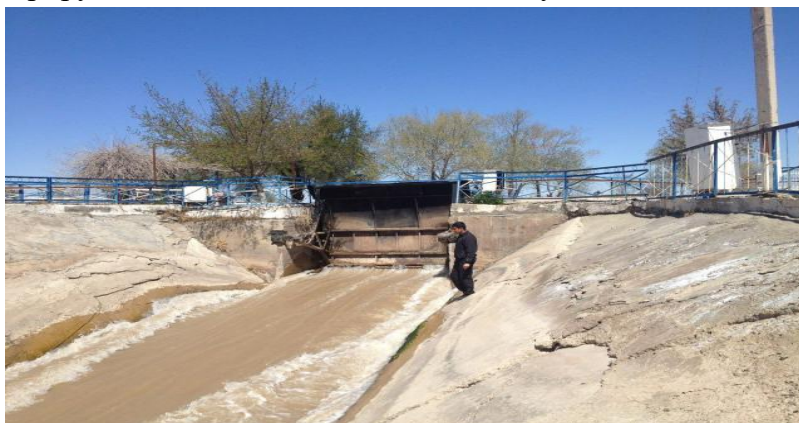
Рис. 5. Водораспределительное сооружение «Коза» (Вабкентский район)
