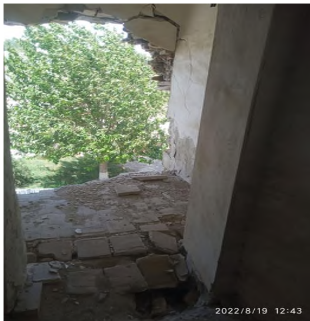
2-расм. Мадраса деворларидаги дарзларнинг очилиши ва емирилиши жараёнлари
