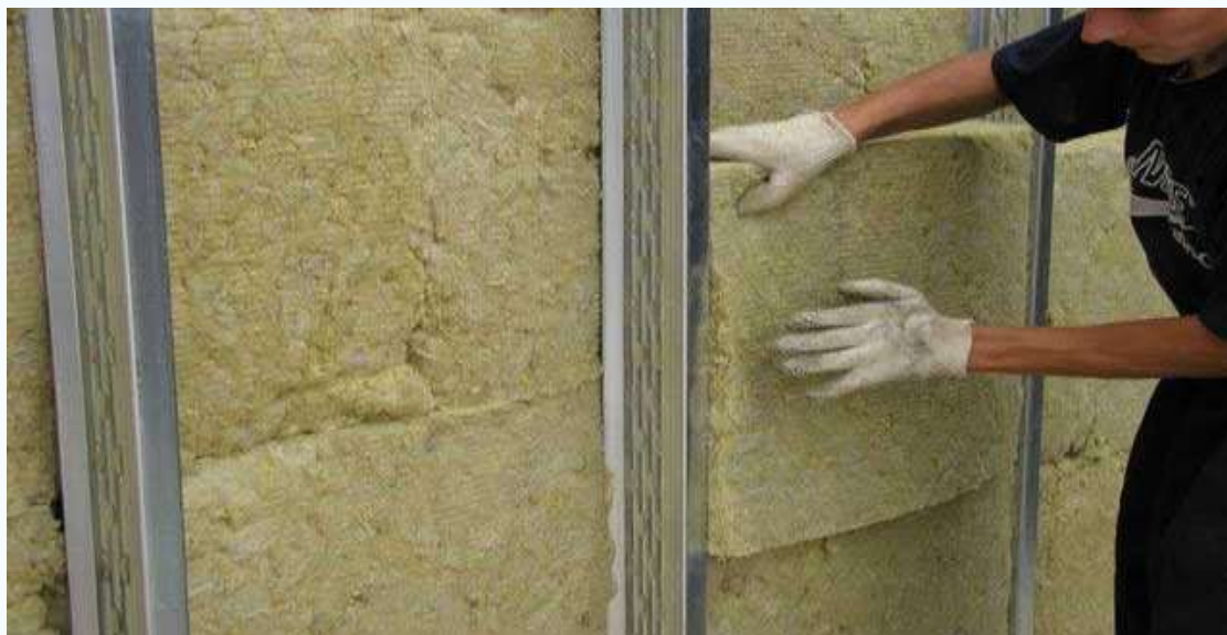
4-rasm. Bazalt toshidan issiqlik saqlovchi plitalarini ishlatish jarayoni
