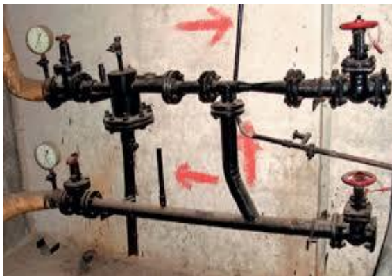
Рис.9. Существующая схема элеватора
