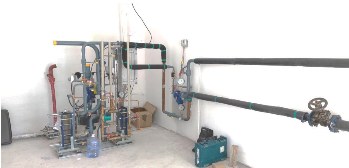
Рис.8. Подключение ИТП к системе теплоснабжения
